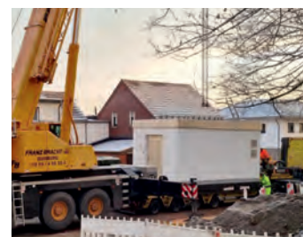
Anlieferung des POP-Gebäudes (zentraler Infrastrukturknoten- punkt des Glasfasernetzes) in Broich
